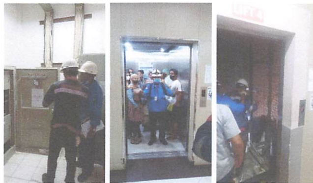
Gambar 5. 3 Dokumentasi uji riksa utilitas penting
